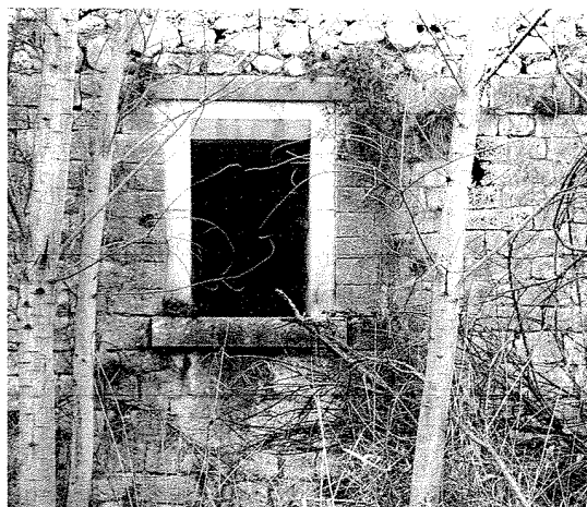
Detalle sillares en la Carretera
